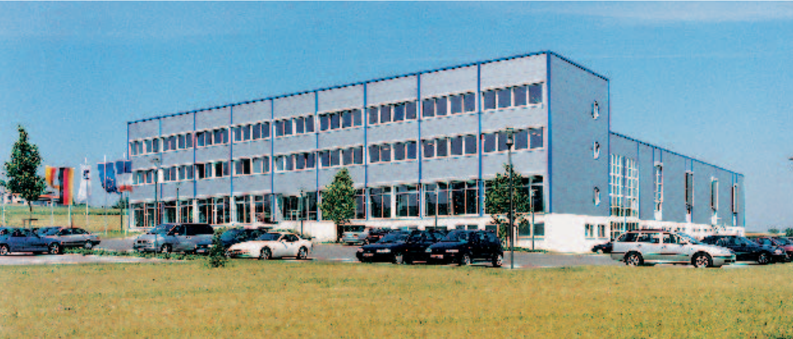
HAM Fabrik 2000, Schwendi-Hörehausen HAM new plant 2000, Schwendi-Hörehausen
