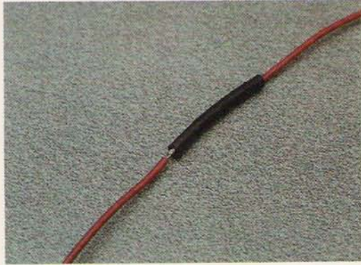
A vezeték összerasztása előtt valamelyikre olyan hosszúságú műanyag zsugortömlőt húzunk, amely kissé túlnyúlik a csúszó vezetékreszen
